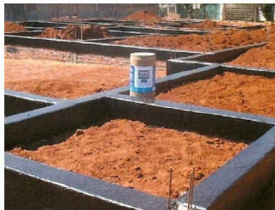
Figura 7 – Impermeabilização das vigas baldrame com membrana asfáltica à frio. (Righi, 2009)
