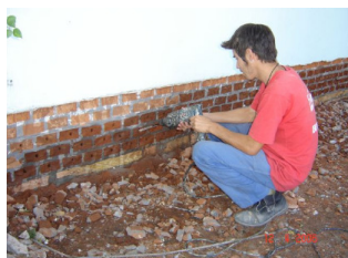
Figura 4 – Aplicação de cristalizantes na forma de pintura. (RIGHI, 2009)
