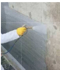
Figura 3 – Aplicação de cristalizantes na forma de pintura. (DA CUNHA E. H., Notas de Aula)
