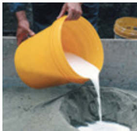
Figura 2 – Preparação da argamassa com aditivo hidrófugo. (VIEIRA, 2005)
